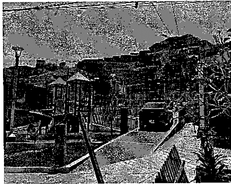
Fotografía N°17: Se visualiza el parque Sector M2.
